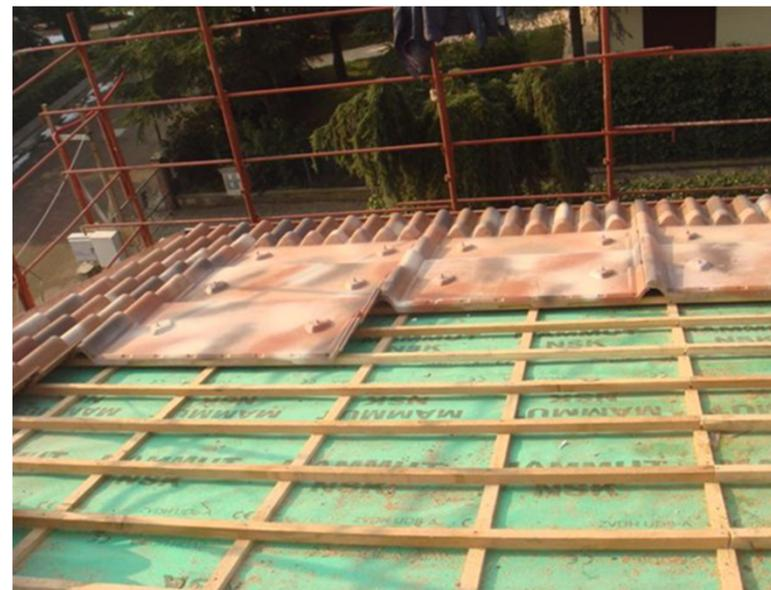
Una soluzione alternativa alla realizzazione della «vasca» in metallo è l'inserimento di elementi di copertura sagomati al fine di posizionare i moduli fotovoltaici.
